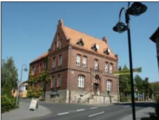
Bahnhofstraße 13: Das alte Bürgermeisteramt (heute Zahnarztpraxis), erbaut 1897 (?) als Pfarrhaus, 1947 im Tausch an die Gemeinde, zunächst Nutzung als Schulgebäude.
