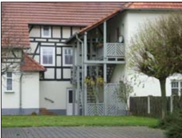
Sackgasse __, aus einer alten Schreinerei wurde ein altengerechtes Mehrfamilienwohnhaus.
