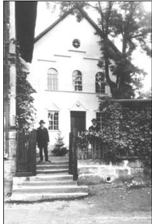
Die 1846 erbaute Synagoge nach der Renovierung 1928. Rechts der Gemeindeälteste Moritz Neuhaus, links sein Vetter Josef Neuhaus.
