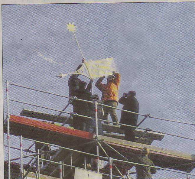
In luftiger Höhe hieven die Männer die neue Wetterfahne der Burgkirche an ihren Platz. Bürgermeister Schmidt fotografiert das Ganze.
